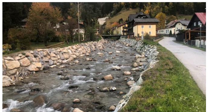
Uferverbauung Unterlauf in Badbruck
